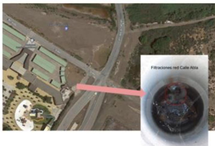
POZO EN DESUSO CON FILTRACIONES
