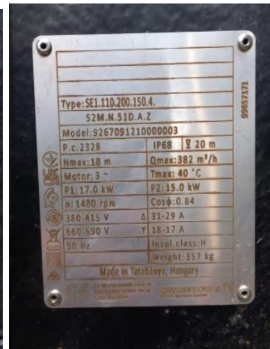
Ilustración 16: Placas de los bombeo a discos textiles. Se incluye también la bomba de agua de dilución para limpieza química de las membranas (izq).
