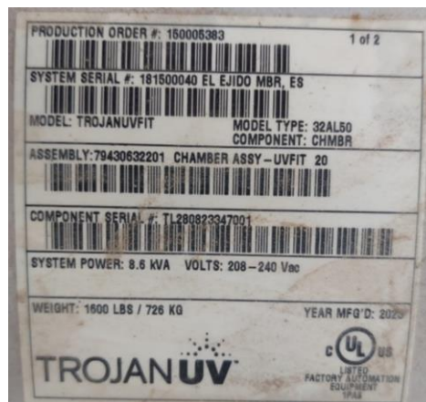
Ilustración 18: Placa del armario (izq) y del equipo de desinfección UV B (der) de la línea MBR.
