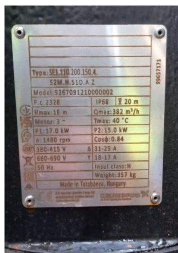
Ilustración 16: Placas de los bombeo a discos textiles. Se incluye también la bomba de agua de dilución para limpieza química de las membranas (izq).
