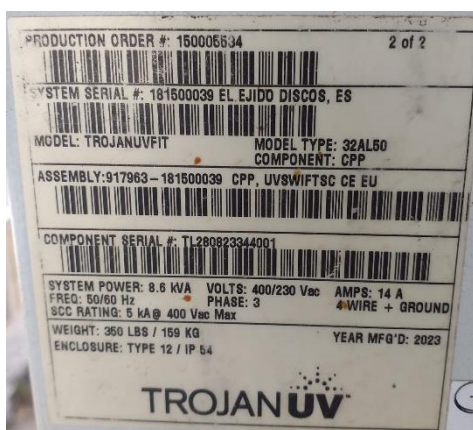
Ilustración 20: Placa del armario (izq) y del equipo de desinfección UV A (der) de la línea convencional.
