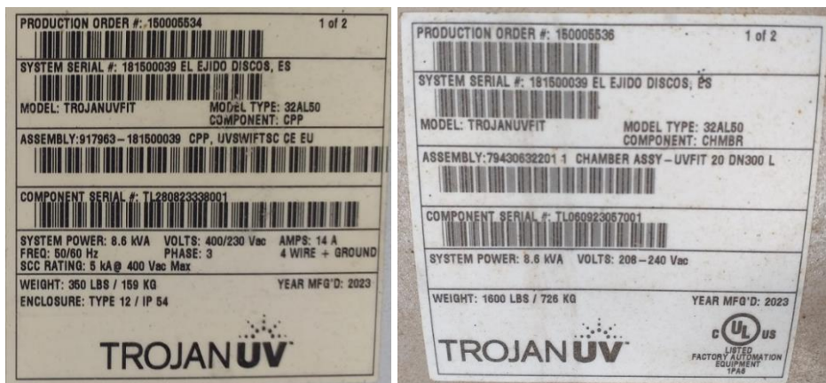
Ilustración 21: Placa del armario (izq) y del equipo de desinfección UV B (der) de la línea convencional.
