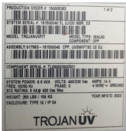
Ilustración 18: Placa del armario (izq) y del equipo de desinfección UV B (der) de la línea MBR.
