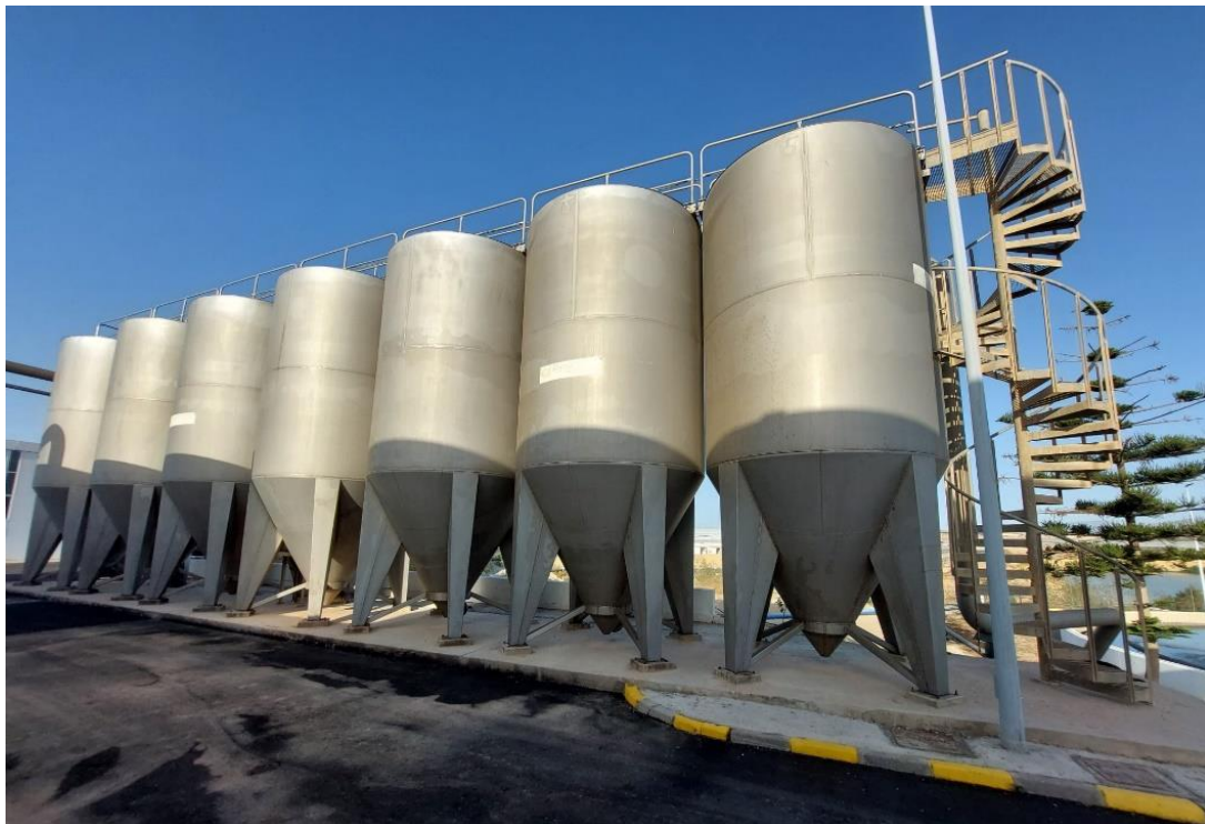
Ilustración 1: Filtros de arena de limpieza en continuo.
