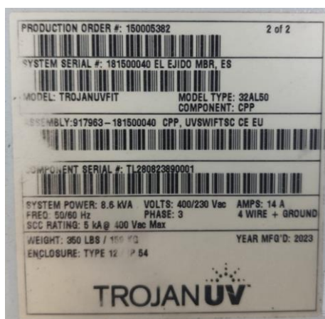
Ilustración 19: Placa del armario (izq) y del equipo de desinfección UV A (der) de la línea MBR.
