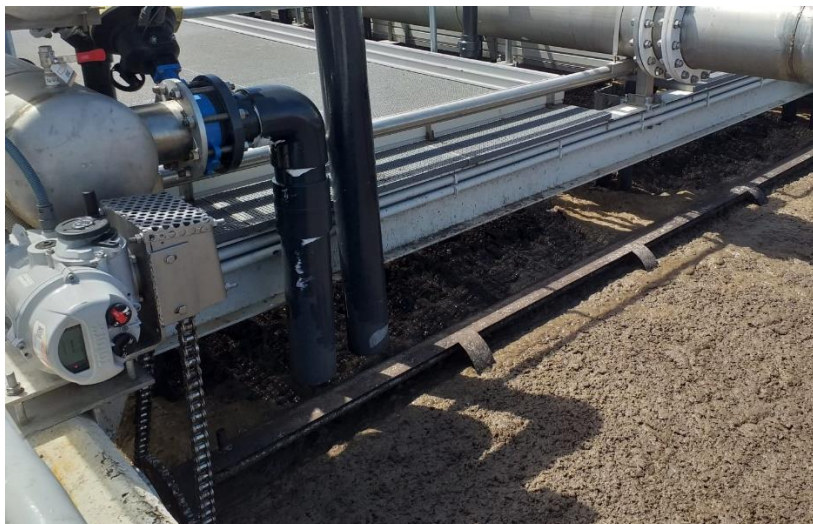
Ilustración 14: Skimmer para la extracción de flotantes del MBR.
