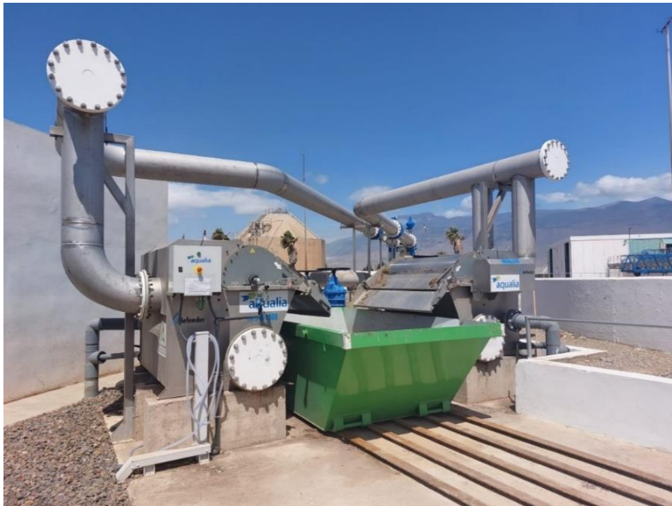
Ilustración 7: Tamices rotativos.
