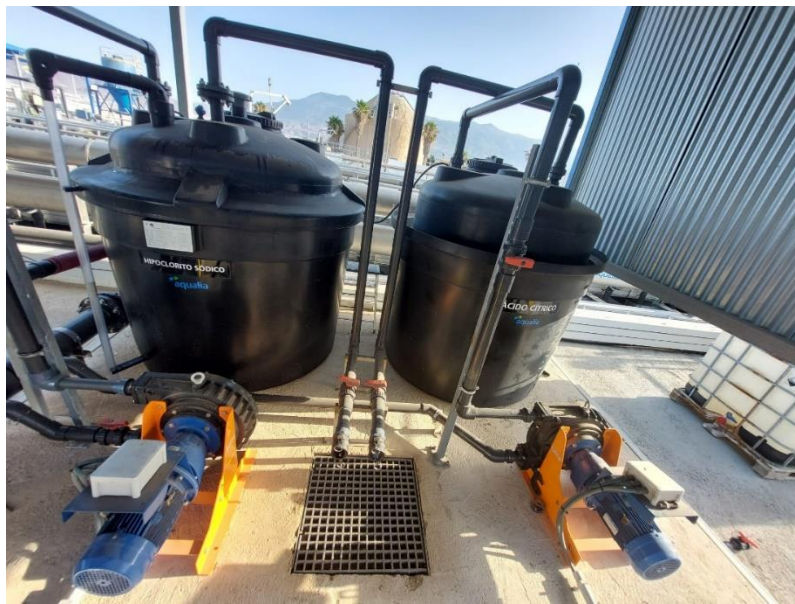
Ilustración 12: Sistema de limpieza de membranas.
