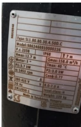
Ilustración 16: Placas de los bombeo a discos textiles. Se incluye también la bomba de agua de dilución para limpieza química de las membranas (izq).
