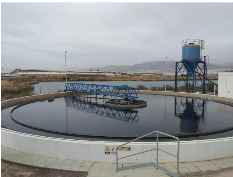
Imagen del decantador secundario en la actualidad
