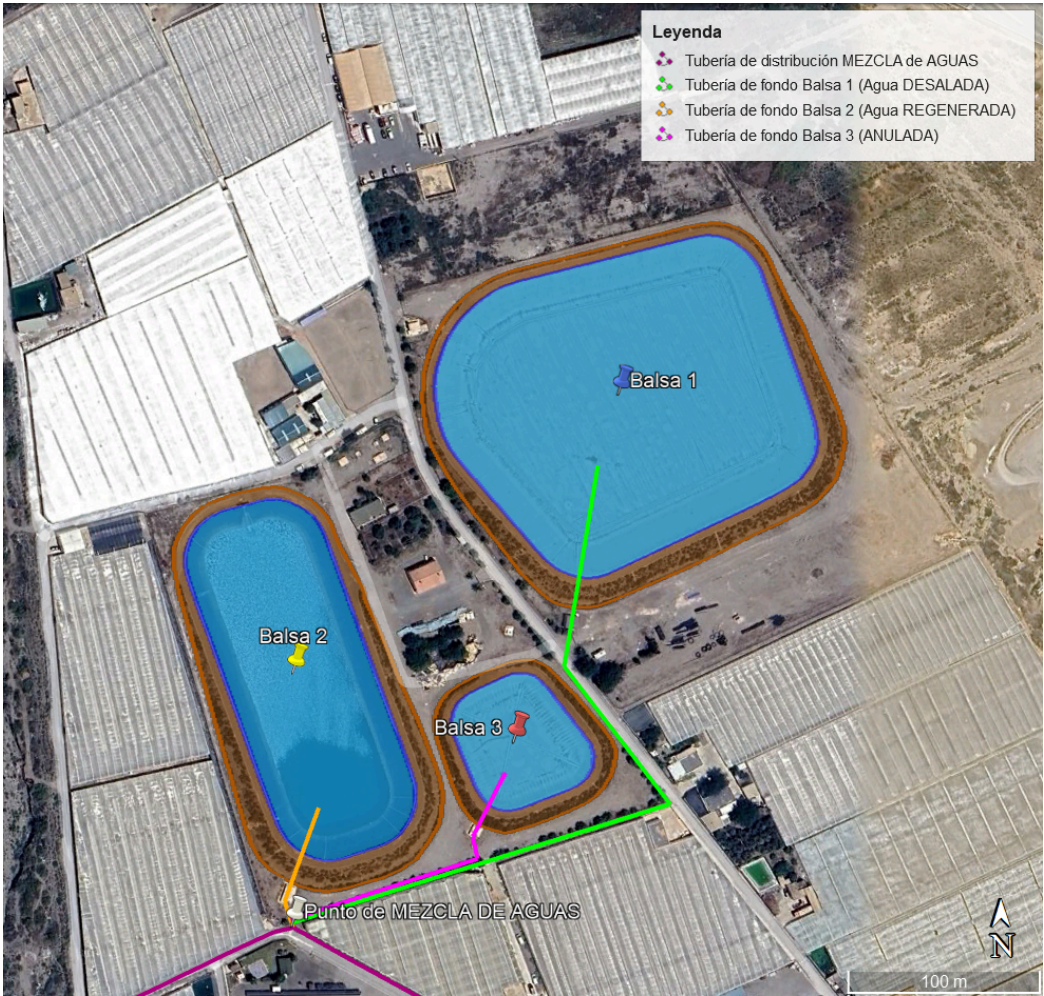
Foto: Sistema de Balsas de Cañuelo.
