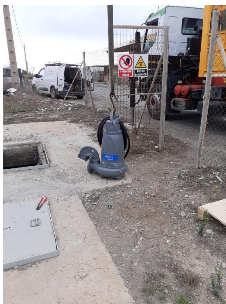
Proceso de colocación de ambas bombas en EBAR Ponte del Río
