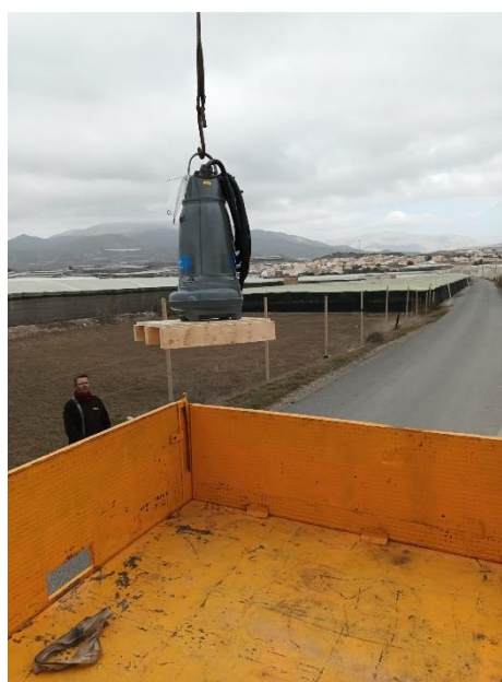
Proceso de colocación de ambas bombas en EBAR Ponte del Río
