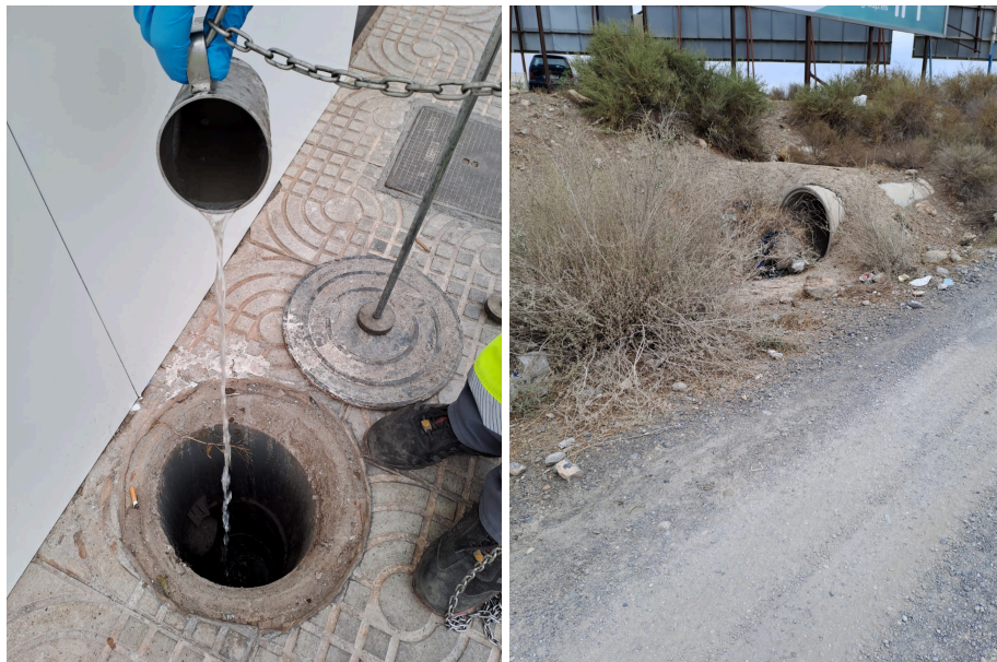
Foto izquierda: arqueta de saneamiento situada en el exterior de la nave de la empresa Zenagro.
