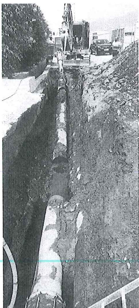
Tubos de PVC DN250 instalados con ventosa sustituyendo los de FD DN400 hasta conectar con tramo original
