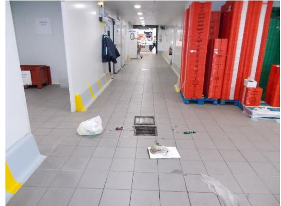
Fotografías 4 y 5. Arqueta de toma de muestras en zona de cámaras y arquetas de paso.
