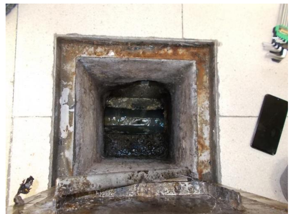
Fotografías 2 y 3. Situación e interior de arqueta de toma de muestras en zona de tienda.
