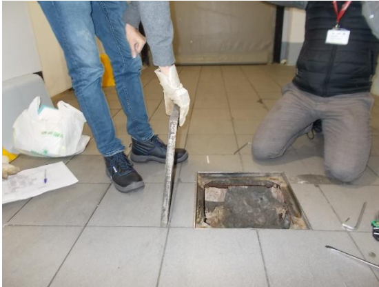
Fotografías 4 y 5. Arqueta de toma de muestras en zona de cámaras y arquetas de paso.
