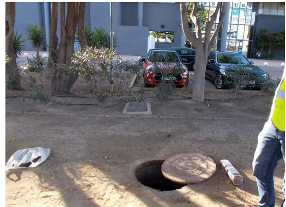
Fotografías 6 y 7. Zona de carga y punto de vertido de aguas de la galería comercial y los aseos de personal (única conexión a saneamiento público registrable).
