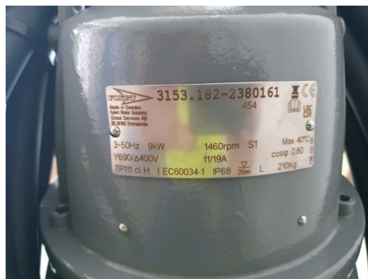
Placas de características de ambas bombas de EBAR Puente del Rio
