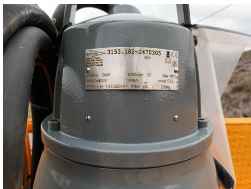
Placas de características de ambas bombas de EBAR Puente del Rio
