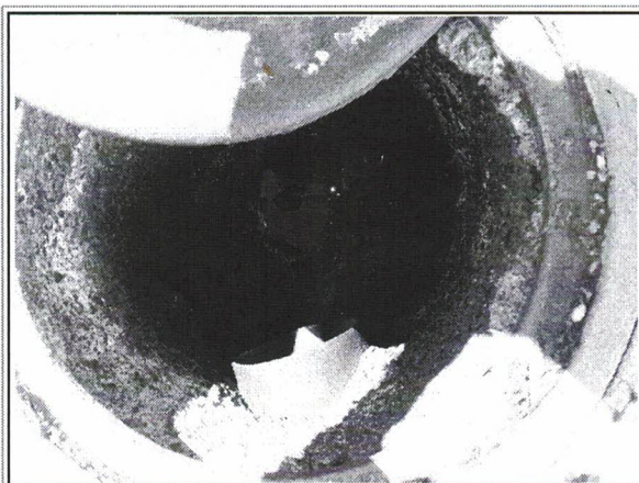
Arqueta frente a almacén X=522529 Y=4071227
