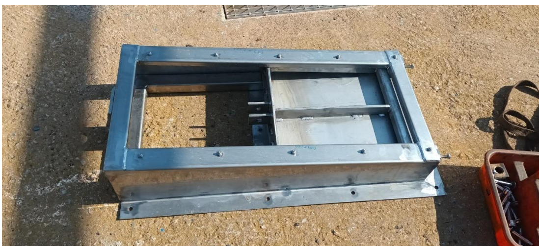
Compuerta de decantador secundario B hacia recirculación desinstalada y la nueva que se ha instalado
