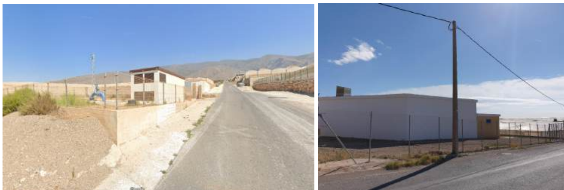
Figura 5.2.7 _A43. Pozo Santa María del Águila (izquierda) y depósito de Santa María del Águila II (derecha).
