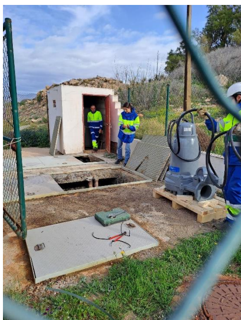
Instalación de bomba en EBAR Paraíso
