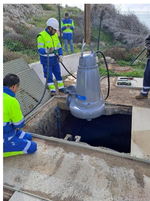
Detalles de la bomba instalada en EBAR Paraíso del Mar
