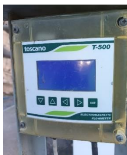
Ilustración 2: Display del caudalímetro de la EDAR de Dalías.
