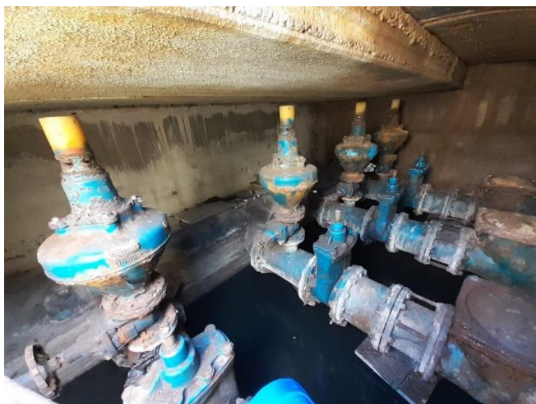
Ilustración 1: Estado de las ventosas de EBAR Géminis
