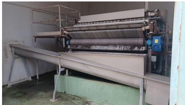
Vista de filtro banda, tornillo transportador, cinta transportadora y contenedor de fango.
